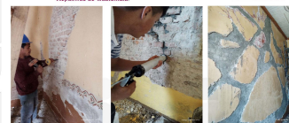
En las tres imágenes de fuente propia se observa el proceso de consultación de figuras de los muros por medio de impresión, confirmando el material gubernizado inspeccionando así el agarre o pegue de la mampostería de ladrillo tuyo.
